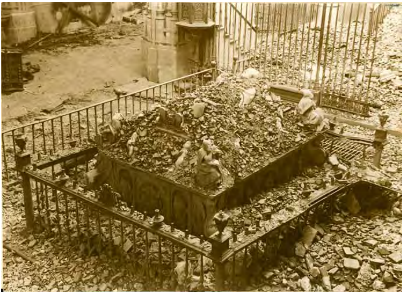
Figura 3. Estado del sepulcro de Cisneros cubierto de escombros tras el desplome de las bóvedas de la Magistral de Alcalá de Henares. Donación Vaamonde Horcada. IPCE. Ministerio de Cultura.
